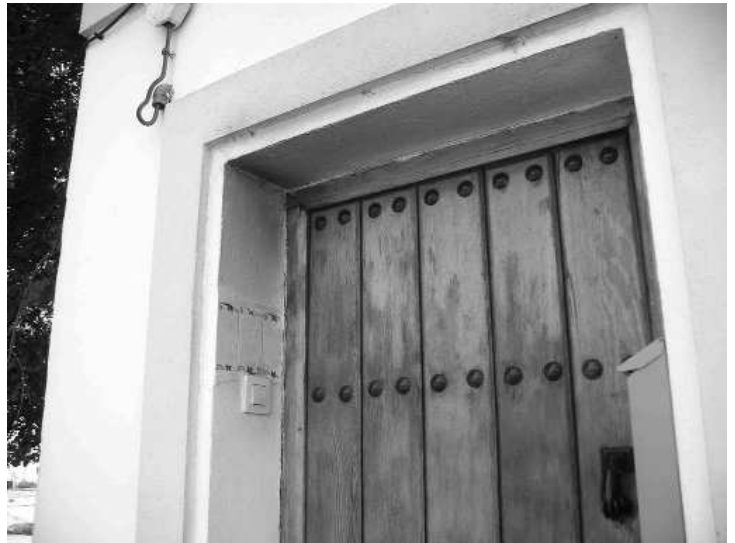
Puerta de Masía Catalana
